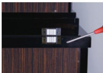
③木部の割れ防止の為に、まず、下穴をキリ等であけてから、プラスのドライバーでネジ留めする。
